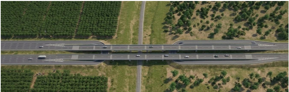
รูปที่ 5.2-5 สะพานข้ามทางรถไฟ (กม.4+400 - กม.5+000)
