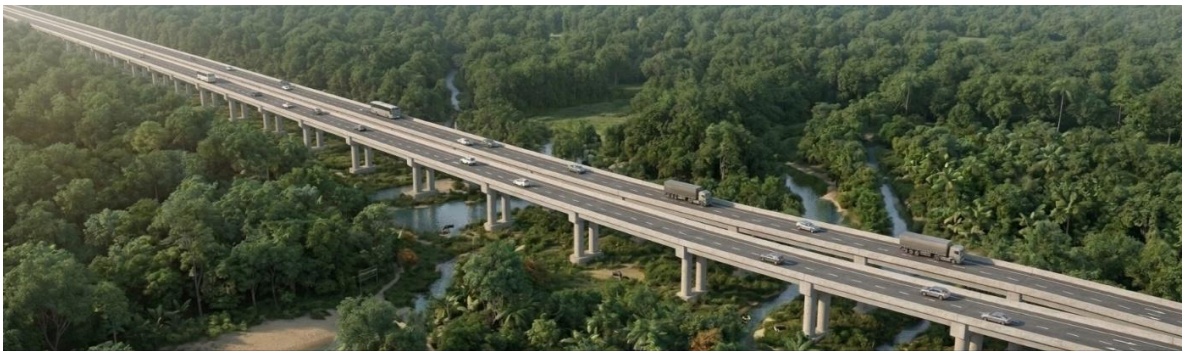
รูปที่ 5.2-6 สะพานบดข้ามพื้นที่เขตรักษาพันธุ์สัตว์ป่า (กม.5+900 - กม.8+125)
