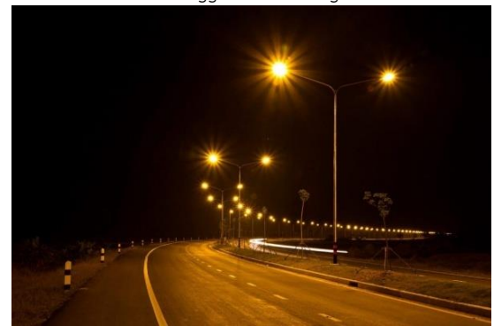
การติดตั้งที่เกาะกลาง (Medium Placing)
