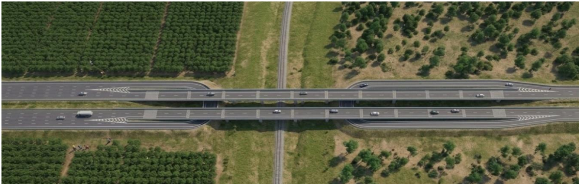
รูปที่ 5.2-5 สะพานข้ามทางรถไฟ (กม.4+464.400 - กม.4+801.600)
