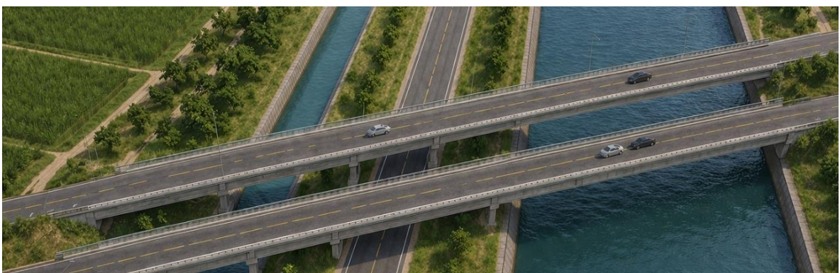
รูปที่ 5.2-7 สะพานข้ามคลองชลประทาน (ไต่แดง) (กม.9+938.650 - กม.10+405.850)
