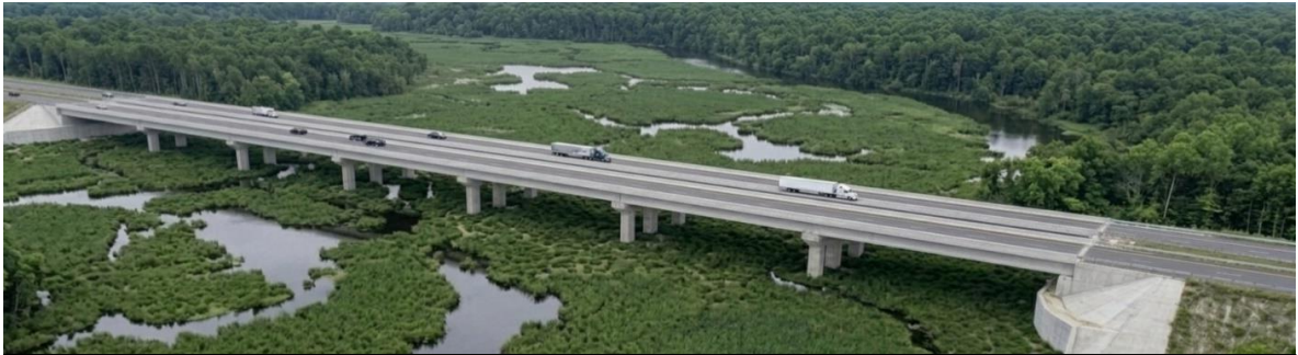
รูปที่ 5.2-4 สะพานบกข้ามพื้นที่ลุ่มรับน้ำ (กม.3+070.000 - กม.3+450.000)
